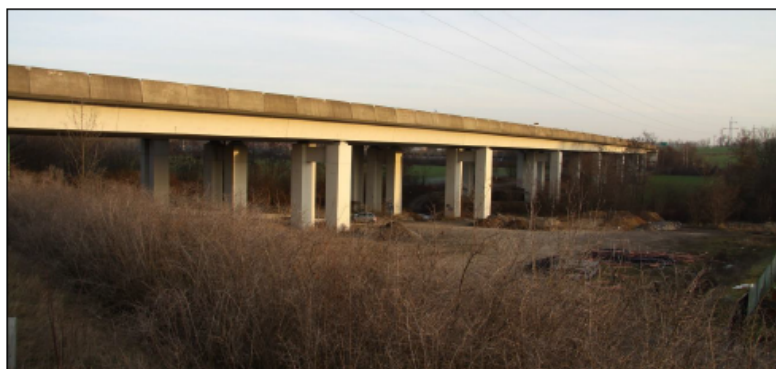
Obr. 11 Dálniční most D8 umožňující bezpečnou migraci živočichů jak pod dálnicí D8, tak i pod budoucí trasou VRT.
