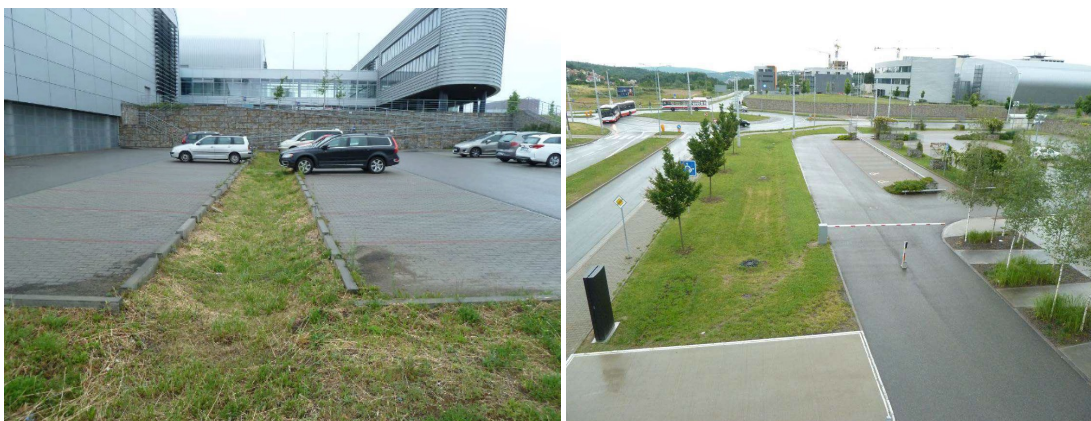
Příklad řešení: vsakovací průleh v kombinaci s řešením odvodnění zpevněné plochy pomocí mezer mezi obrubníky (kampus Masarykovy univerzity v Brně). Příklad řešení: Vsakovací průleh – rýha, využití zelené plochy mezi silničními pruhy městské dopravní sítě (Brno, ulice Netroufalky).
